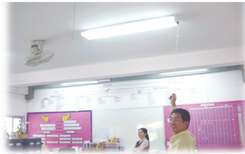
รูปที่ 3-2.2 การติดตั้งสวิตช์กระตุกเพื่อปิดหลอดไฟที่ไม่ได้ใช้งาน
