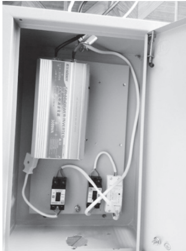
ภาพที่ 6 ติดตั้งวงจรควบคุม
