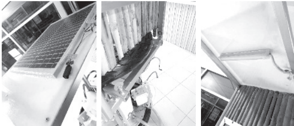
ภาพที่ 3 ฐานวางโซล่าเซลล์ ติดหลอดไฟ LED และติดตั้งที่วางแบตเตอรี่
