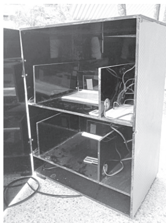
ภาพที่ 5 การสร้างและติดตั้งอุปกรณ์ไฟฟ้า
