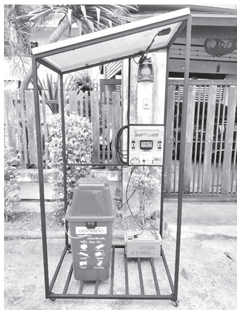
ภาพที่ 4 การติดตั้งระบบโซลาร์เซลล์กับถังขยะใช้พลังงานแสงอาทิตย์
