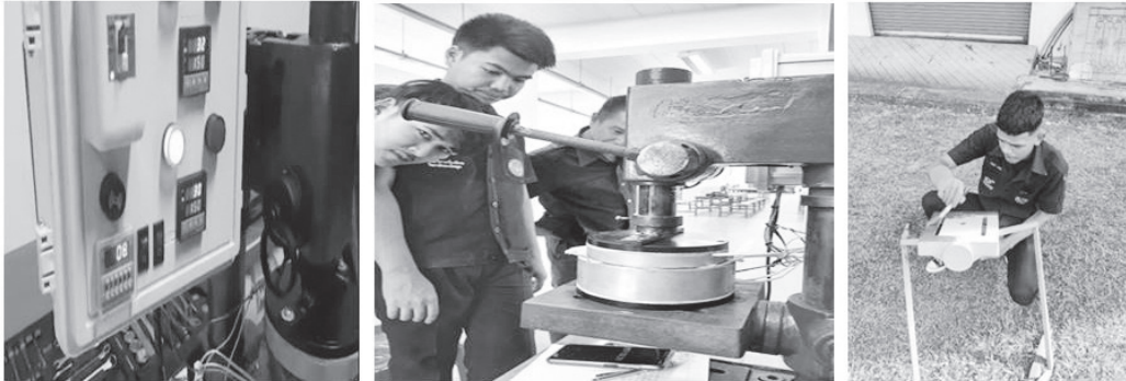
ภาพที่ 6 ต่อสายฮีตเตอร์เข้ากับชุดควบคุมระบบไฟฟ้า ทำการทดลอง และถอดชิ้นส่วนมาทำสี
